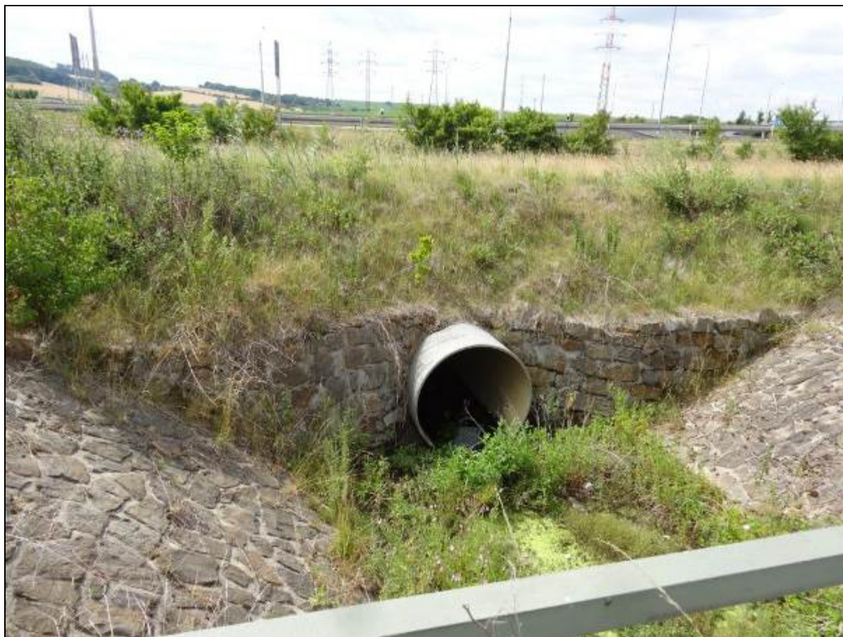
Obr. 10: Trouba přivádějící meliorační kanál k propustku v km 2,121
